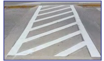
Demarcación peatonal con pintura termoplástica.
